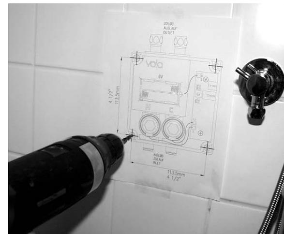
Ventilkasten mit den beigelegten Schrauben montieren.
