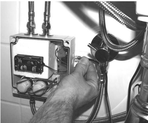
Den Deckel auf den Ventilkasten montieren
